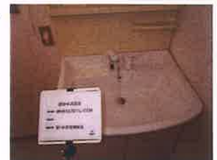
洗面吐水状況
