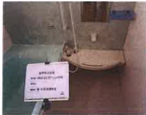
浴室水栓吐水状況
