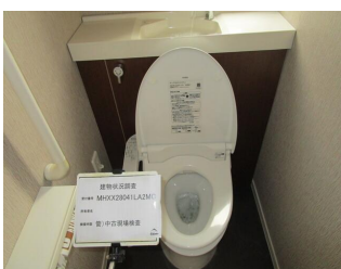
2階トイレ排水状況
