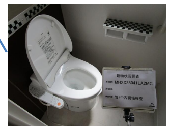
1階トイレ排水状況
