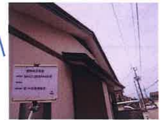
下屋根取合い部
